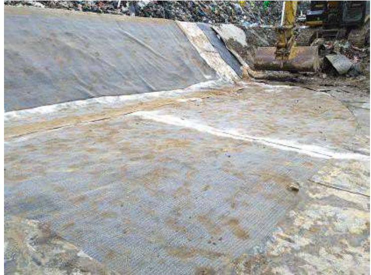
Remplacement et pose du nouveau GSB (géosynthétique bentonitique)
