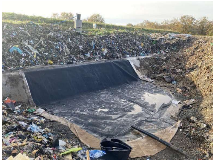
Pose de la nouvelle géomembrane
