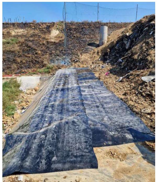
Bâche temporaire faisant office de rustine apposée par l'exploitant suite au sinistre
