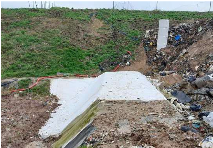
Pose du géotextile supérieur
