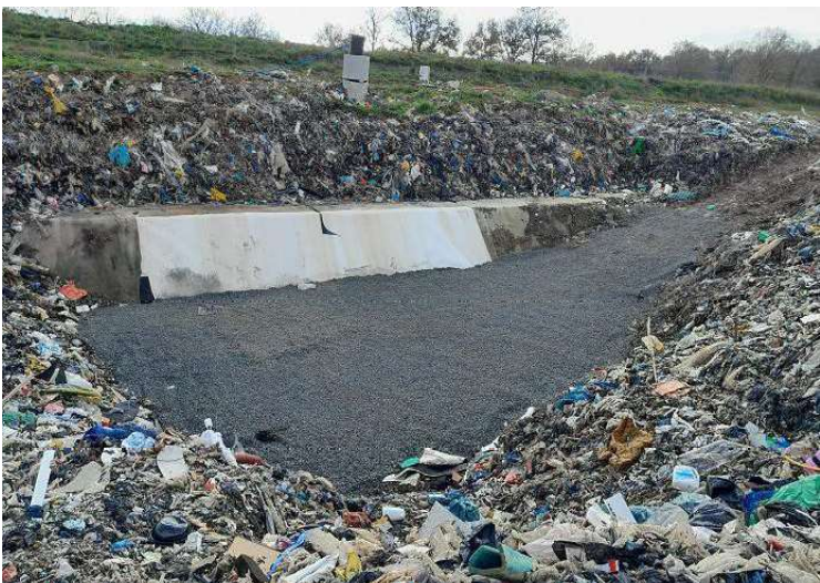
Pose de la couche drainante de fond de casier
